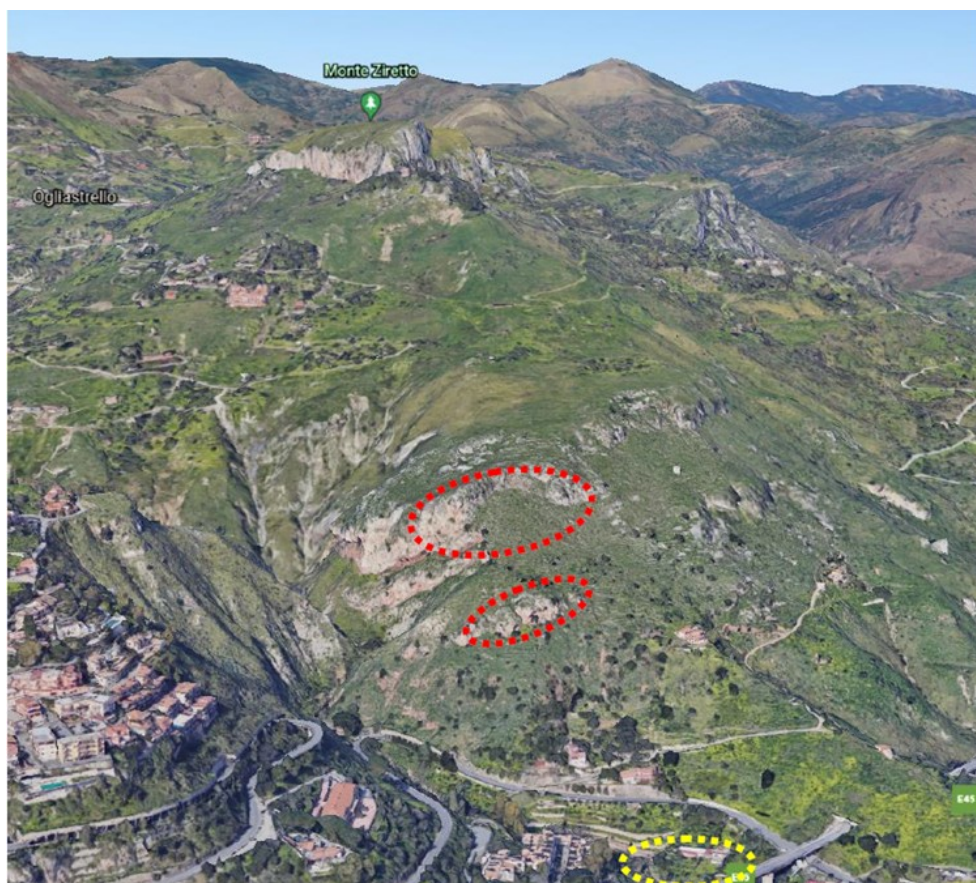
Figura 5: Visualizzazione prospettica del settore oggetto di studio. In giallo il settore dell'uscita Lato Mare della Stazione Taormina, in rosso le pareti con i problemi di instabilità
