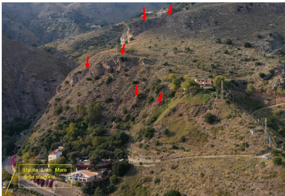
Figura 6: Vista sulle pareti soggette a distacchi
